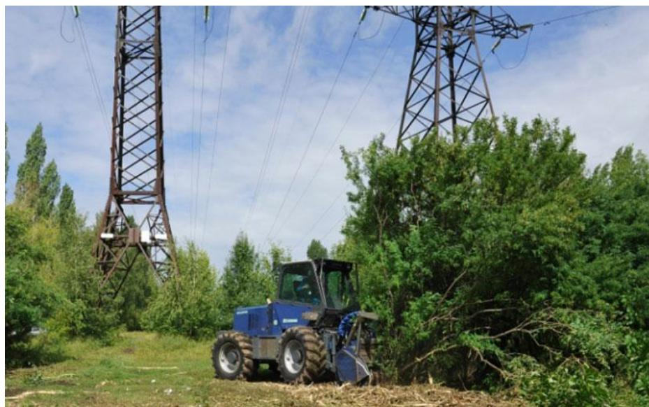
В филиале «Россети Центр Воронежэнерго»\* продолжается планомерная работа по расчистке воздушных трасс линий электропередачи (ЛЭП) от древесно-кустарниковой растительности. Мероприятия проходят в рамках подготовки к отопительному периоду и направлены на обеспечение надежного и бесперебойного энергоснабжения потребителей.
